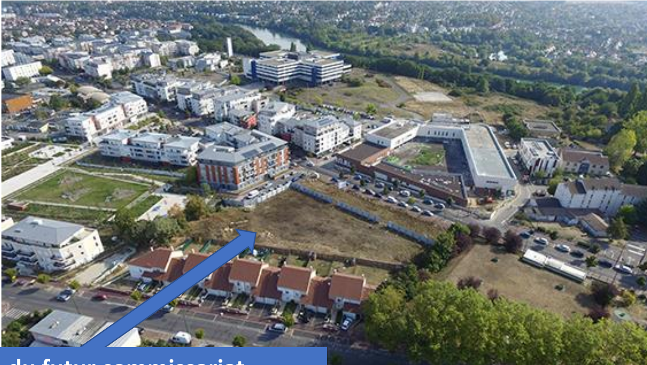
Site du futur commissariat
