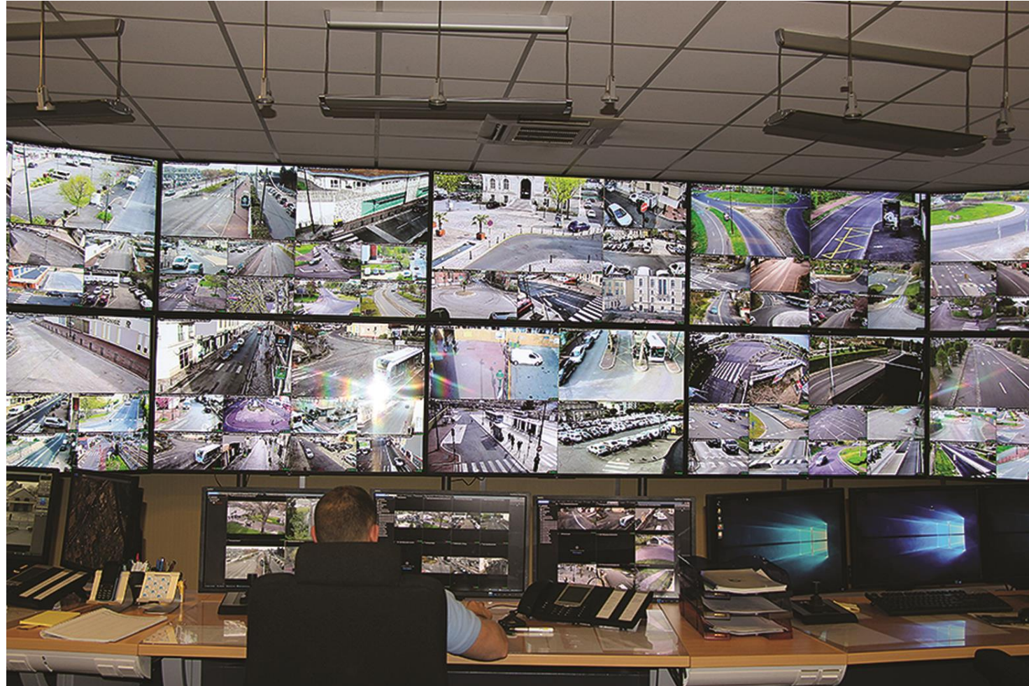
Installation du centre de supervision dans le centre administratif de la commune
