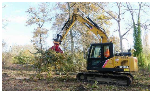
Travaux sur la zone humide © SIARCE
