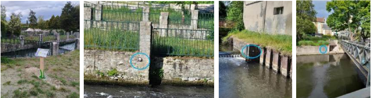
Emplacement du panneau pédagogique et des trois repères de crue (parc Robinson, Moulin-Galant, parking Crété) © SIARCE
