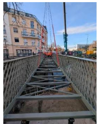
Passerelle de Crété
