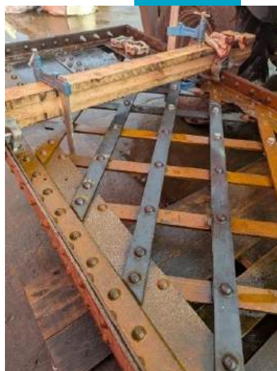
Rénovation de la passerelle de la Barre en atelier
