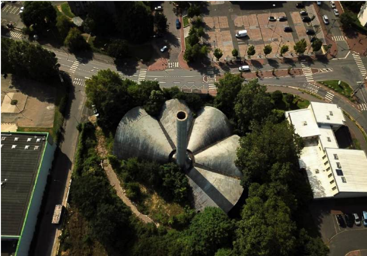
Vue aérienne de l'ancienne chaufferie des Tarterêts, 6 novembre 2024
