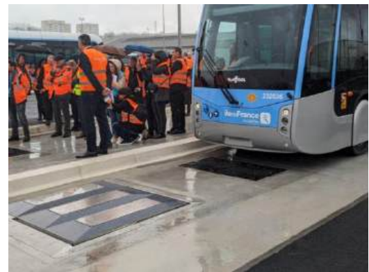
Recharge au sol du Tzen 4
