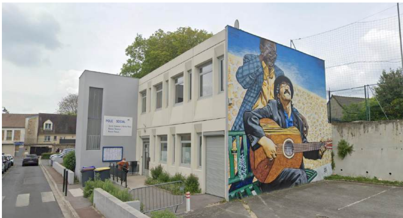
Locaux du CCAS, 4 rue de la Triperie
